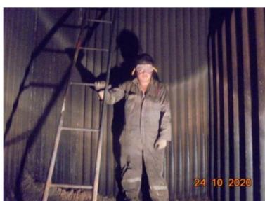
Gambar 8. Pengecekan dan pembersihan jelaga boiler MT.MARLIN 88
