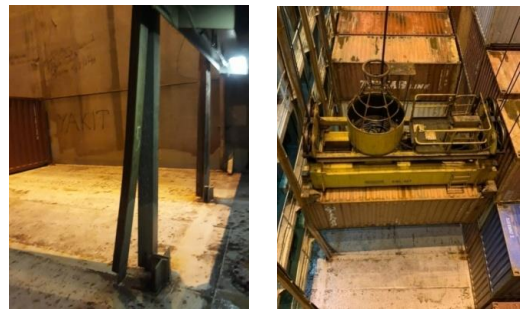
Gambar 1. Kerusakan cell guide di kapal Mv. Izumi Mas.
